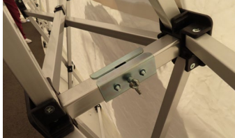
5. 骨組みの隙間を繋ぐように金具で固定する
